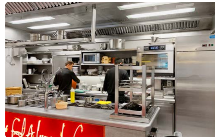
Techo filtrante de 5000x3500 mm con aportación de aire inductora
