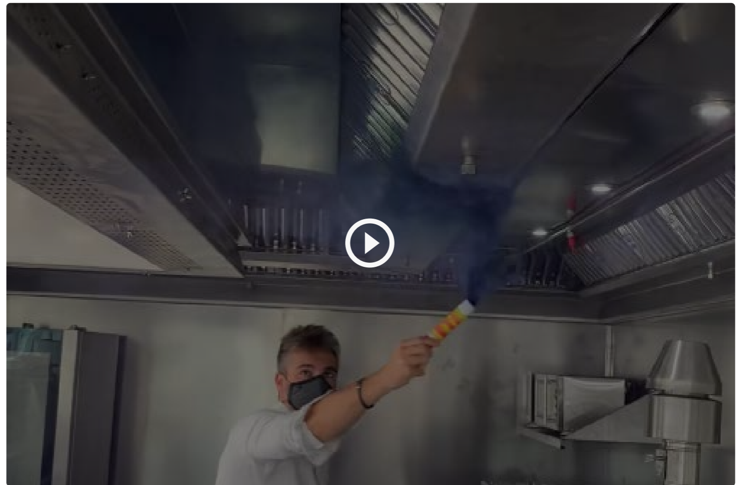
Campana Slim en forma de L de 5000x3000 mm con aportación de aire inductora
