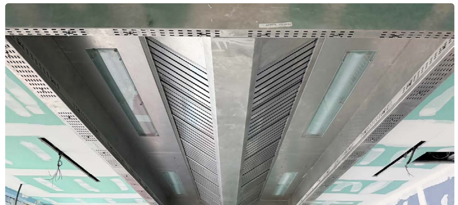
Techo filtrante de 6000x2000 mm Sistema de agua autolimpiante y aportación inductora
